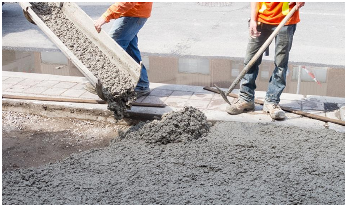
Figura 3: Aplicação de Concreto Permeável in loco
