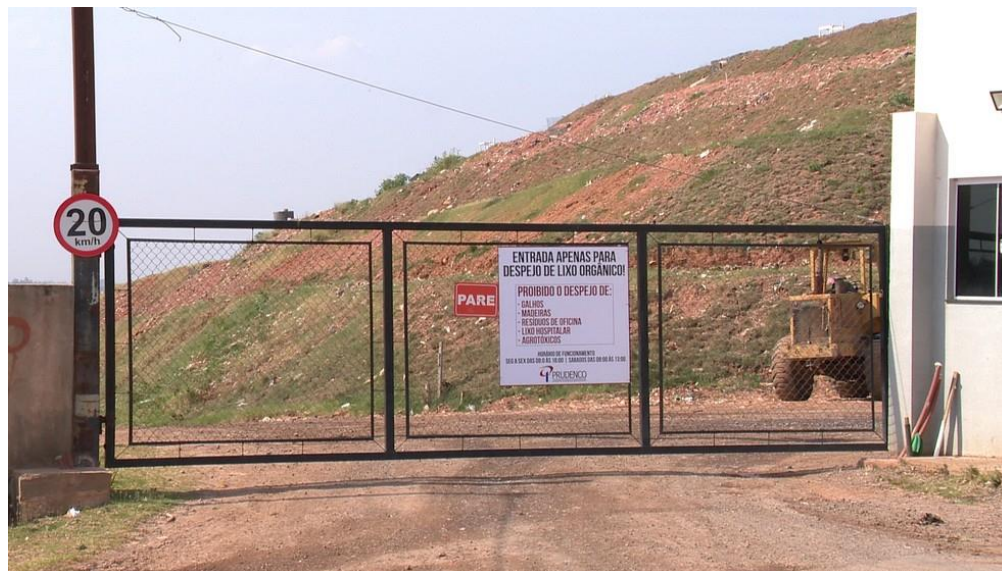
Figura 13 – Encerramento do aterro sanitário em Presidente Prudente.
