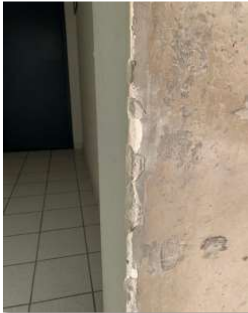
Figura 6 – Pilar desgastado
