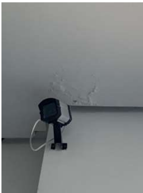
Figura 12 – Umidade Teto
