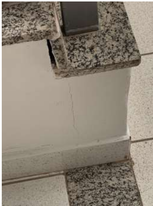
Figura 8 – Fissuras Verticais
