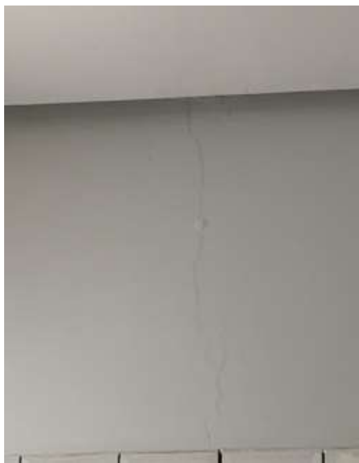
Figura 9 – Fissuras Verticais
