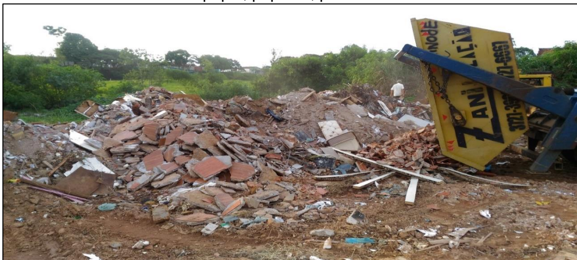
Figura 1 – Argamassa, pisos e azulejos cerâmicos, piso laminado de madeira, papel, papelão, plásticos
