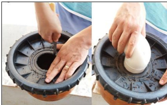
Figura 2 – Acabamento e Posicionamento da Entrada do Tubo
