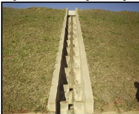
Figura 6 – Descida d'água em degrau
