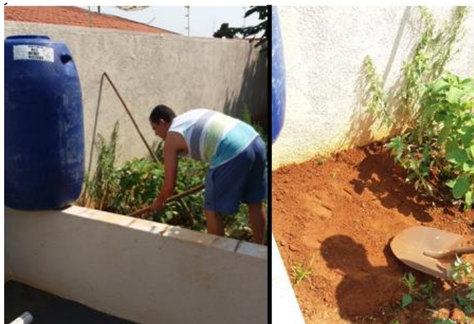
Figura 3 – Nivelamento do Terreno Onde Será Colocado o Reservatório
