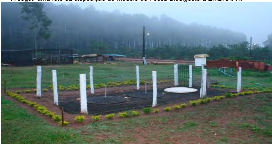
Foto 1. Sistema de fossa séptica devidamente montado e cercado. Fonte: EMBRAPA, 2017.
