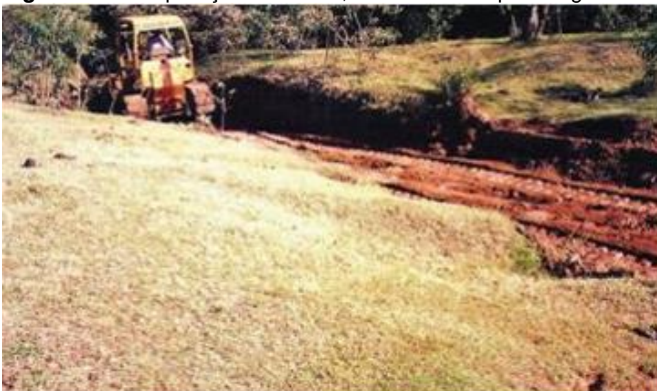
Figura 2 - Recuperação do Dreno, voltando ao dique marginal da Lagoa do Capim
