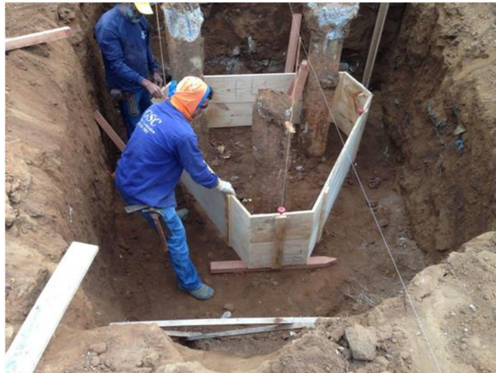
Figura 14: Forma para execução do Bloco
