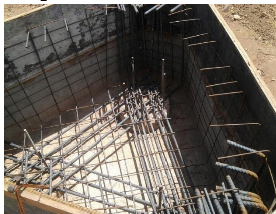
Figura 19: armaduras do bloco
