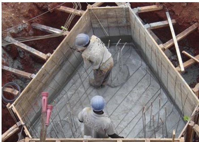
Figura 18: Armadura da Malha e Armadura de Suspensão
