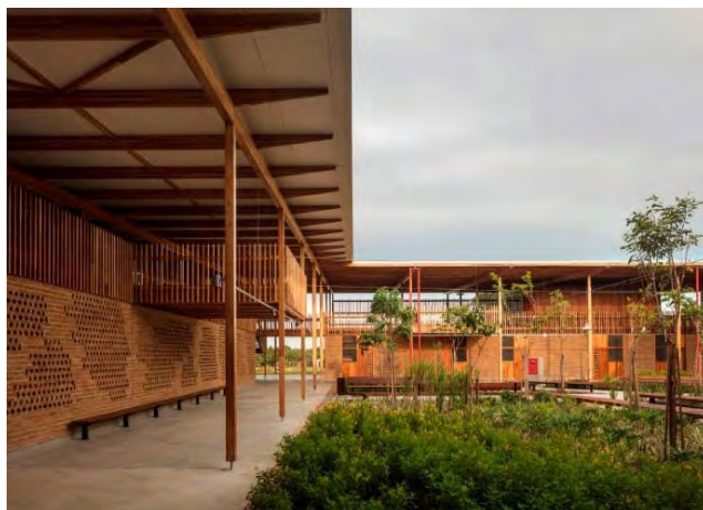
Figura 4 - Centro da Fazenda Canuanã. Fonte: ARCHDAILY, 2017
