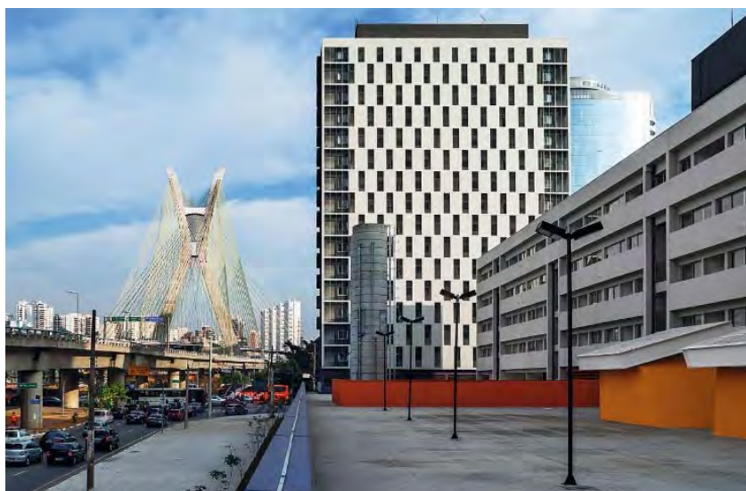
Figura 4 - Ponte Estaiada participa da paisagem do Conjunto Fonte: MMBB Arquitetos, 2013.
