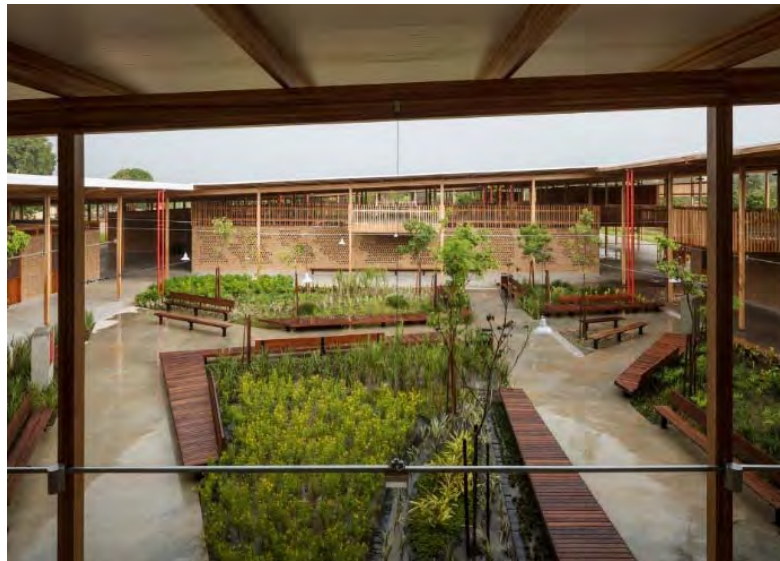
Figura 7 - Pátio aberto. Fonte: ARCHDAILY, 2017.
